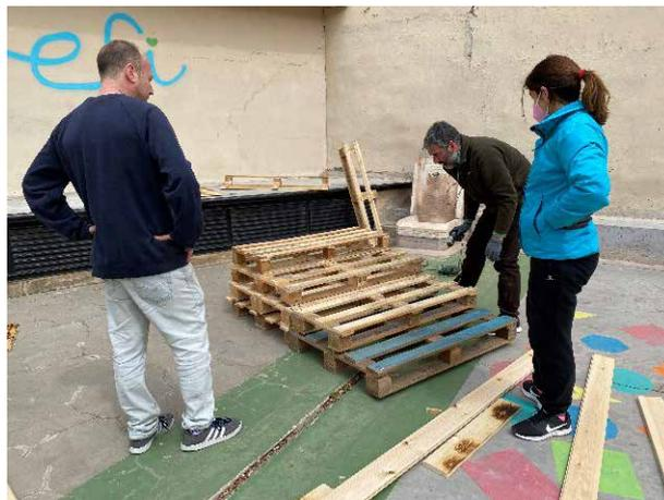
**Figura 32.** Escalinata para acceder al escenario. Se utilizan 5 palets para la estructura y a continuación se forra con tablas de madera ya tratadas con fuego y con aceite de linaza
